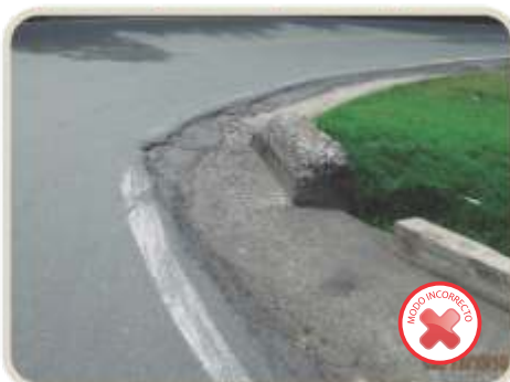
Troncal Occidental (Cerca al Alto de Minas). Obsérvese el deterioro del cabezote de obra
