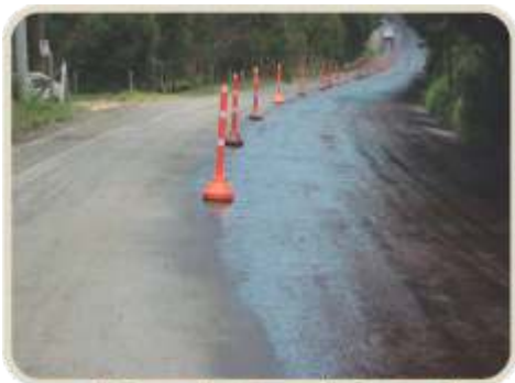
Imprimación media calzada
