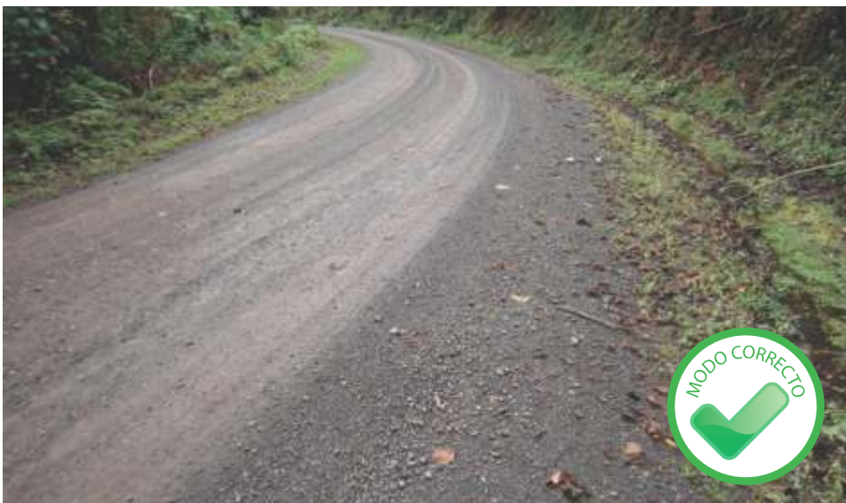
Siete meses después de intervenida aplicando las buenas prácticas
