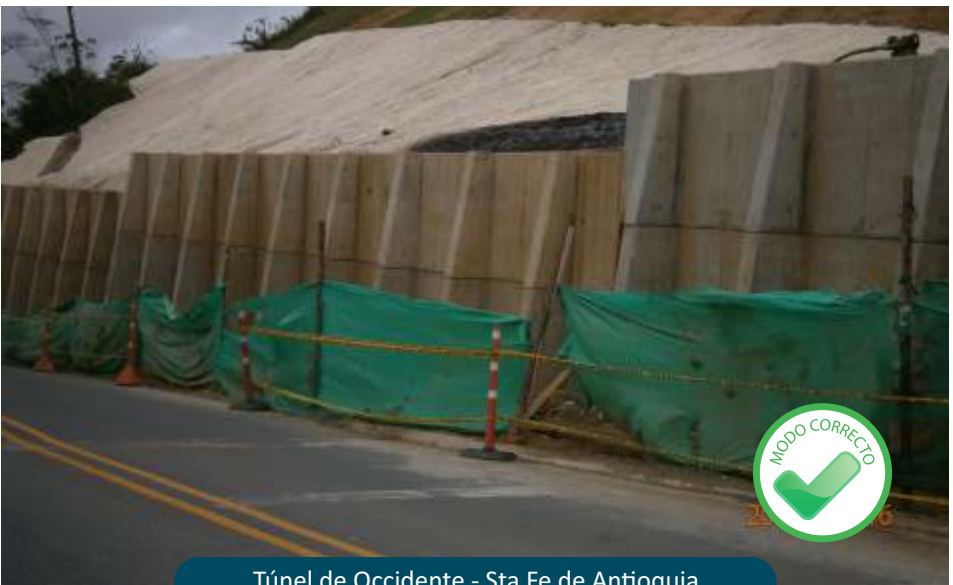
Túnel de Occidente - Sta Fe de Antioquia
