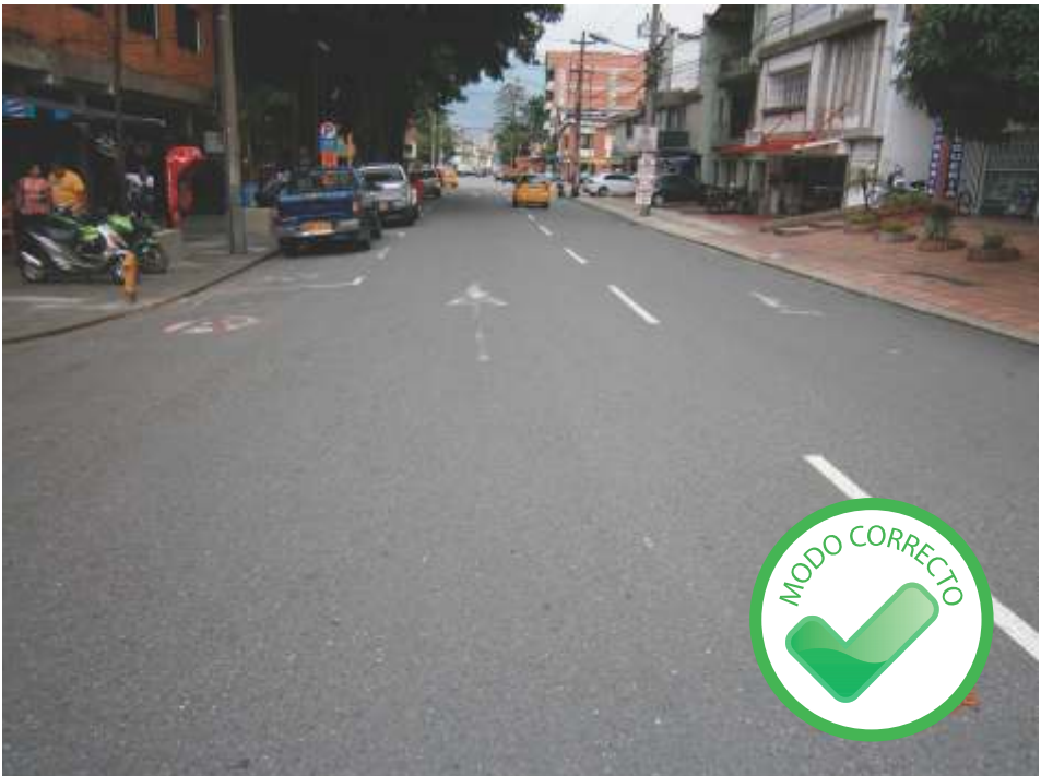
Calle 43 con Carrera 68 - Medellín. Obsérvese el bombeo del 5.5% y berma-cunetas de 10%
