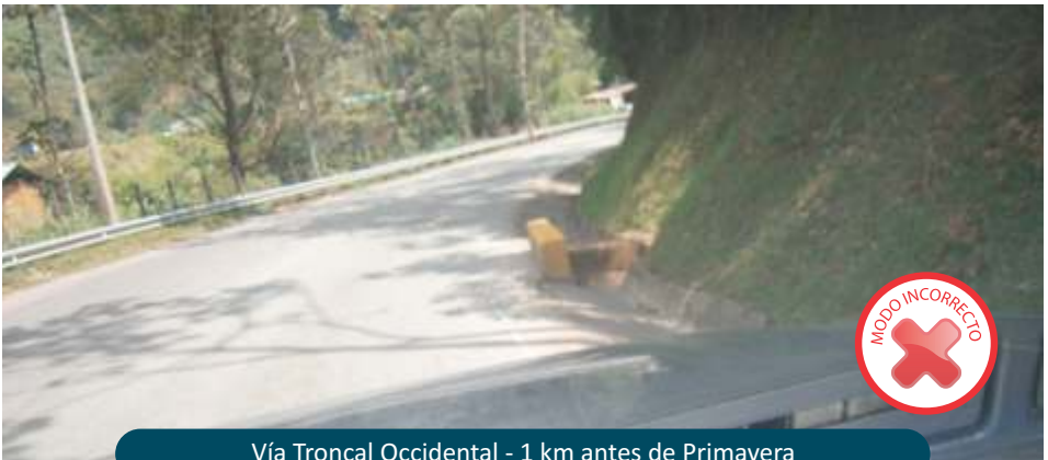
Vía Troncal Occidental - 1 km antes de Primavera
