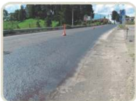
Base imprimida terminada
