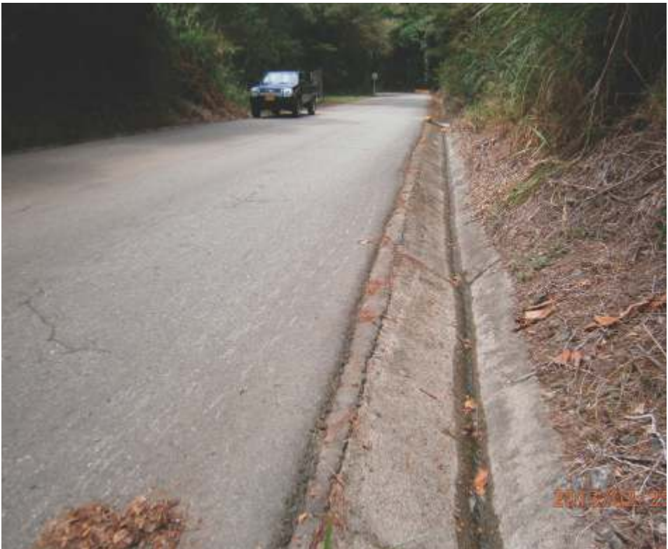
Carretera a la Hidroeléctrica de Niquía
