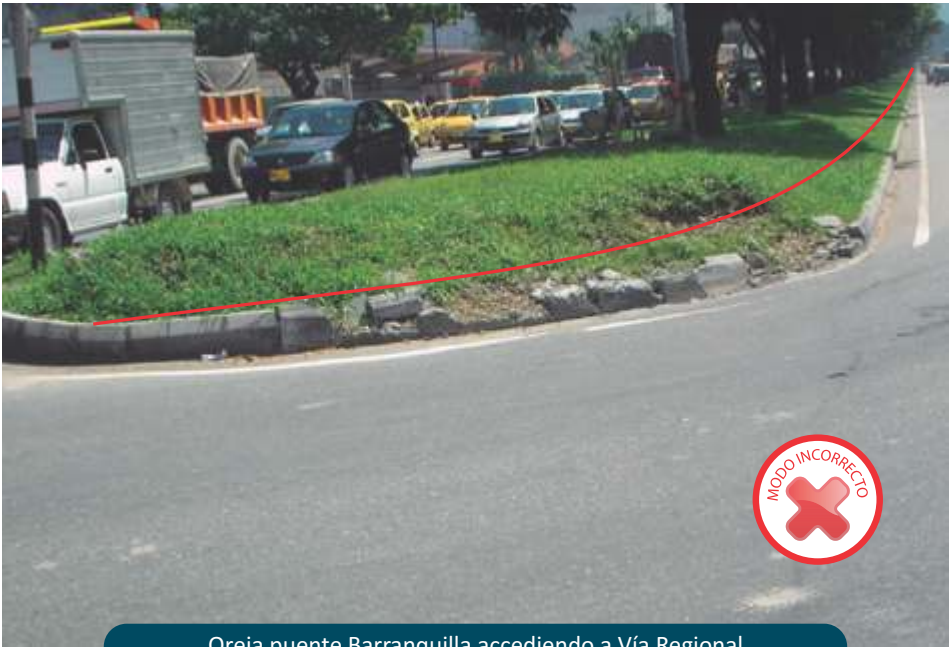
Oreja puente Barranquilla accediendo a Vía Regional
